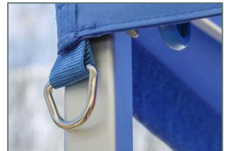
Gurtband mit Metallring zum sichern des Zeltes
