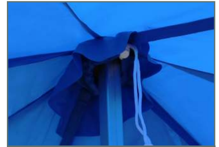
Dachfixierung an der Giebelstange
